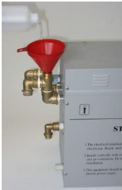
7. Öntse a vízkötlenítő oldatot a tartályba – típustól függően kb 4-9 l
